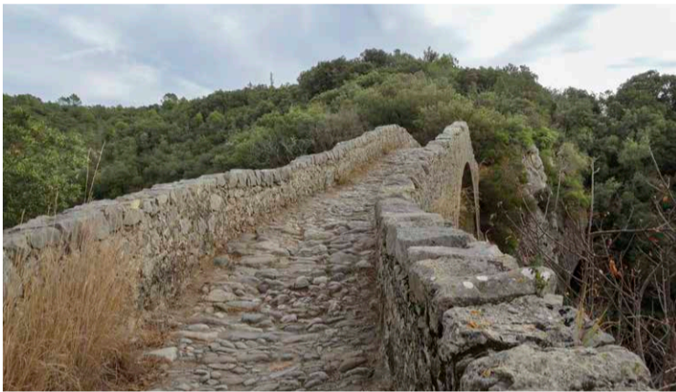
Puente sobre el río Llierca.
