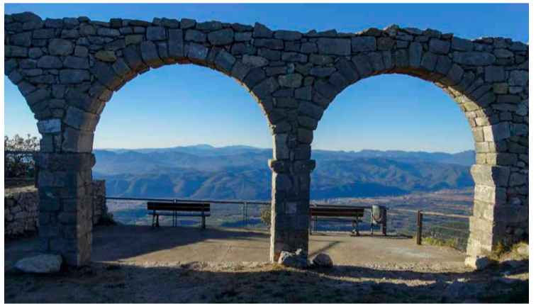
Vistes des del cim del Mont.
